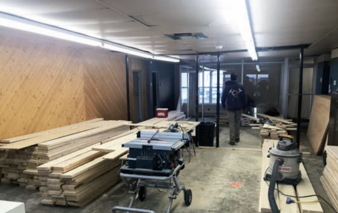
Une partie du bois pour le renforcement des chevrons.
